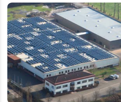
ERGO-FIT in Pirmasens: Hier entstehen auf 9.000 m 2 innovative Fitnessgeräte von einzigartiger Qualität
